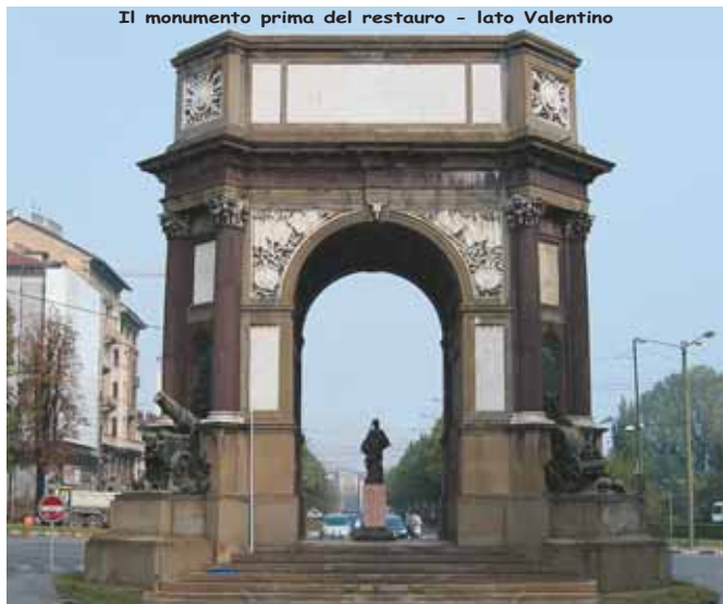
Il monumento prima del restauro - lato Valentino
