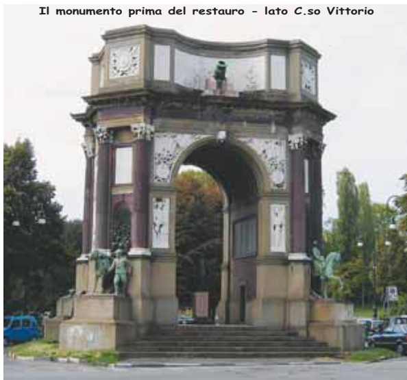
Il monumento prima del restauro - lato C.so Vittorio
